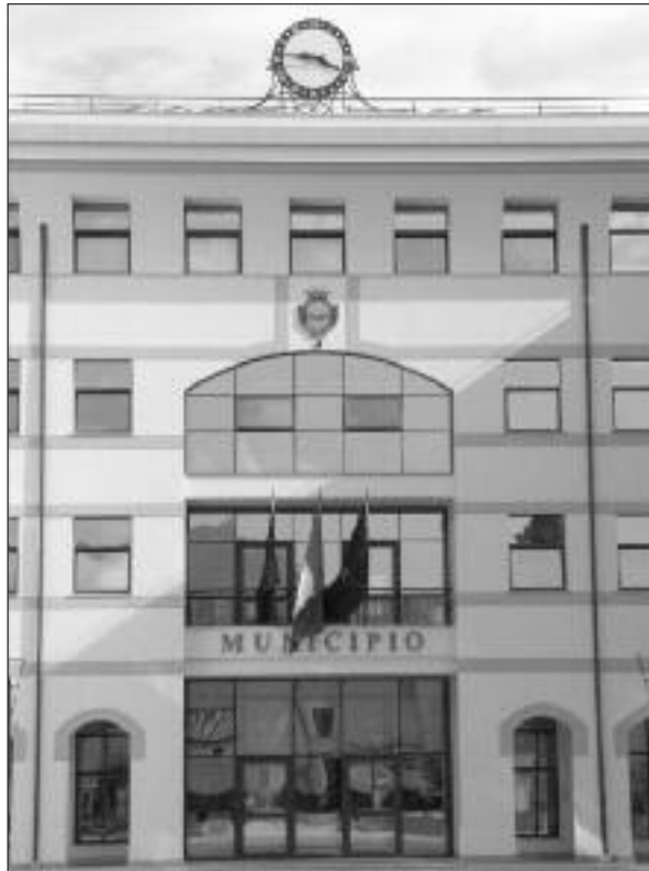
Nuova casa comunale l'ingresso principale
