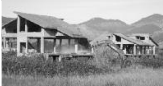
Isola dei Ciurli, la ruspa al lavoro
